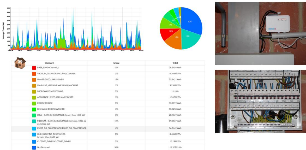
Figure 12: exemple des données récoltées et de l'installation de mesure des consommations électriques
