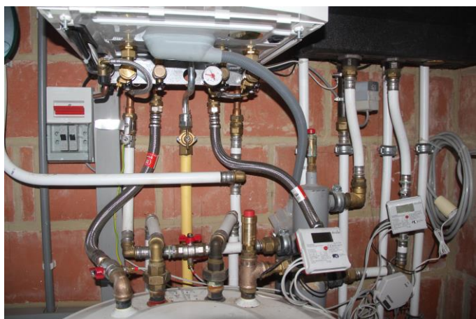
Figure 13 : mesure des consommations pour la production de chauffage et d'eau chaude sanitaire
